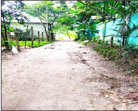
Road-4, Kaliakair Pourashava
