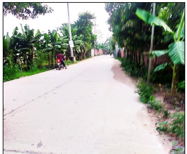
Drain-4, Kaliakair Pourashava
