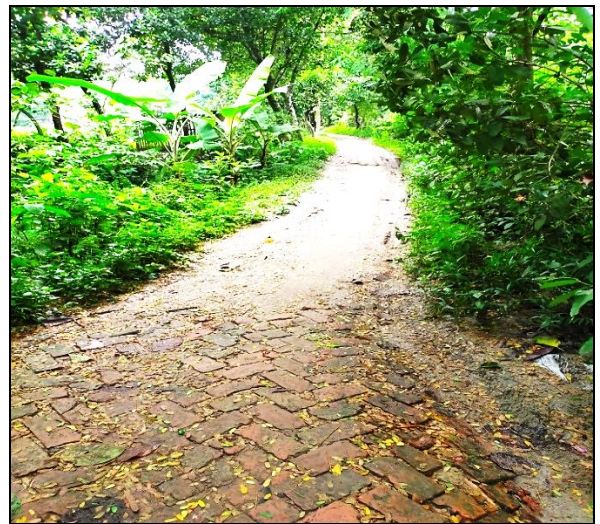
Road- 8, Kaliakair Pourashava
