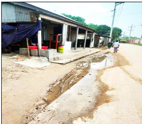
Drain-4, Kaliakair Pourashava
